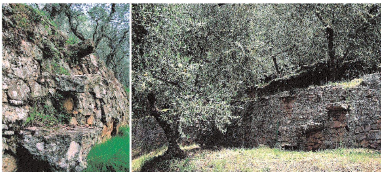
Fig. 28 - Terrazzamenti. Esempio di strutture accessorie: pietre collocate come scalini per il collegamento tra ripiani contigui. [Foto: D. Rizzo]
