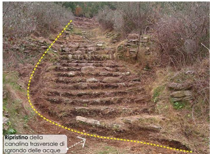
Esempio di intervento su un percorso idraulico-agrario del tipo sentiero gradonato, in cui il ripristino della canalina trasversale di sgrondo delle acque accresce la capacità dell'opera sistematoria nel contenimento dei tempi di corrivazione delle acque di superficie ivi raccolte
