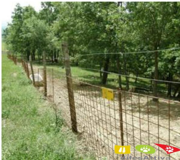
**Figura 19** - Recinzione mista con base realizzata in fogli di maglia elettrosaldata interrata e parte superiore costituita da fili per conduzione elettrica
