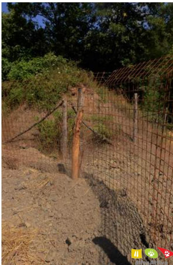
**Figura 6** - Esempio di realizzazione di angoli stondati
