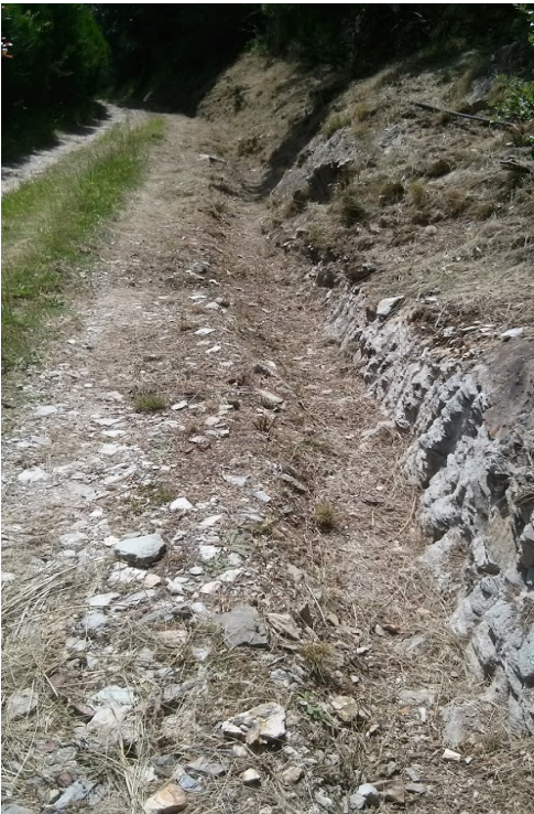
Schema visivo di una corretta regimazione delle acque in una strada poderale
