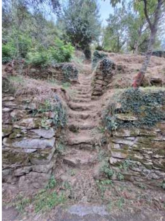
Via di S. Martino Opera di sistemazioni idraulico agrarie Sentiero canaletta a rittochino
