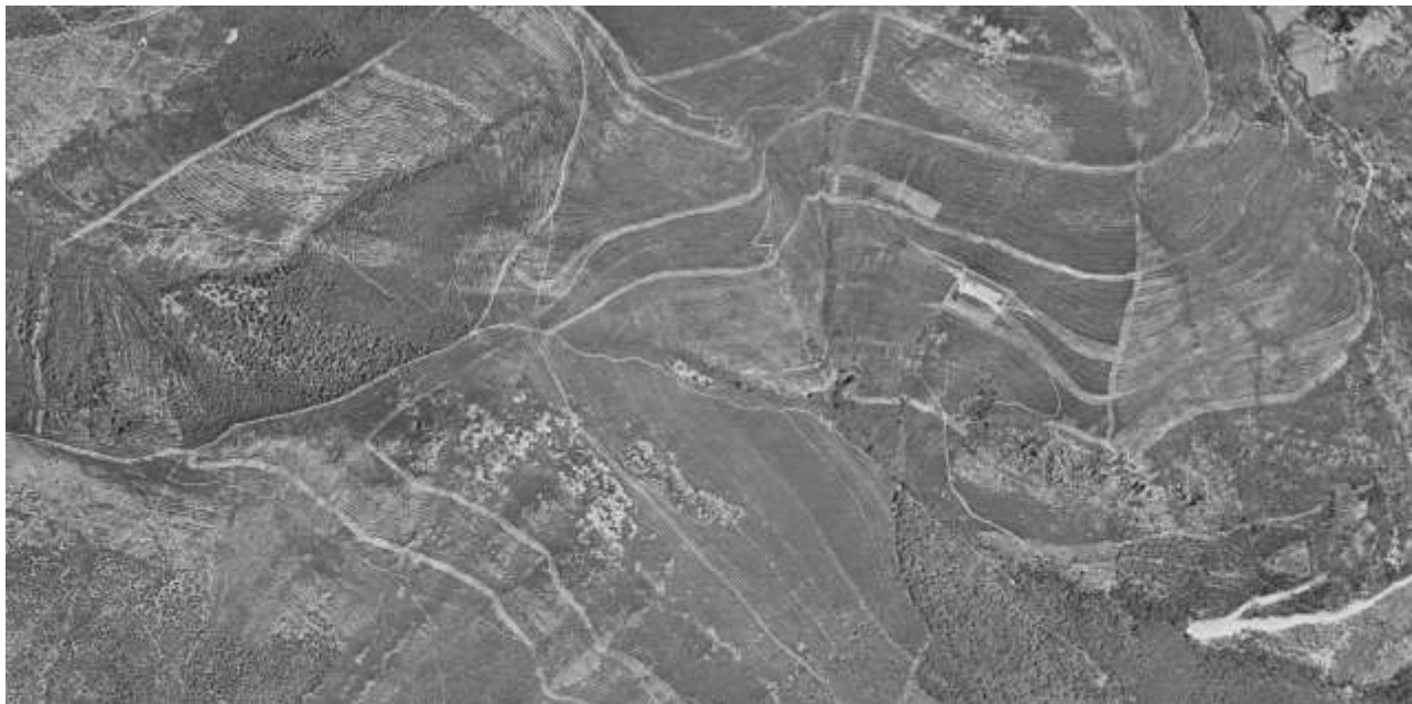
Opere idraulico forestali eseguite dai Piani Fanfani - Foto aerea dell'area a confine tra i territori di Calci e Buti loc. Ceragiola – Le Focelle – Cimone
