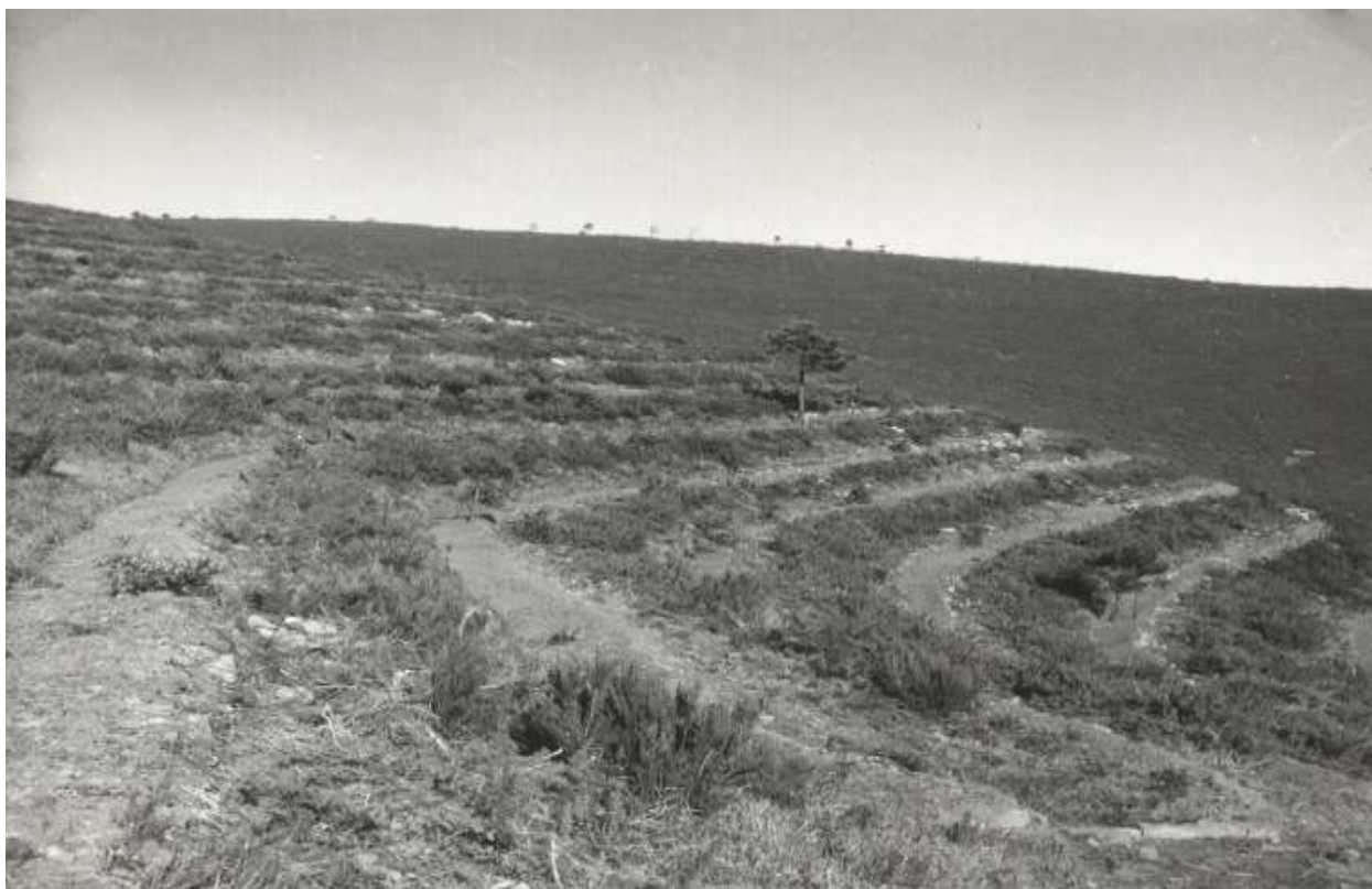
Gradonature di stabilizzazione dei versanti su terreni degradati Foto (*1)
